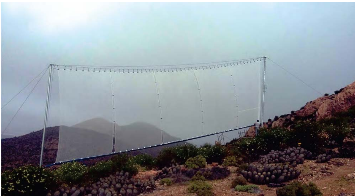
Figura 5. Panel superior. Esquema de funcionamiento de una red atrapanieblas. Panel inferior, un atrapanieblas en el cerro Los Perales de Taltal (Chile). Según Hernández & Tapia (2019).
